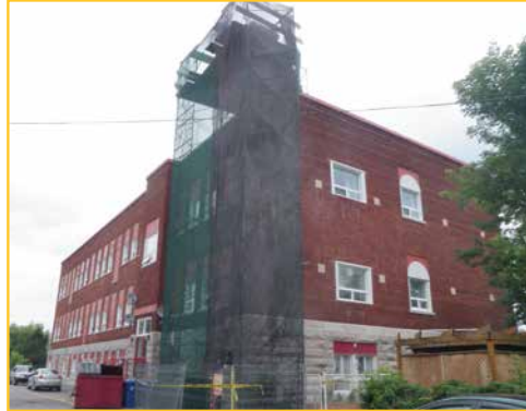
Pavillon Laroque : réparation du parement de briques
