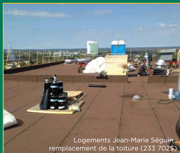
Logements Jean-Marie Séguin : remplacement de la toiture (233 702$)
