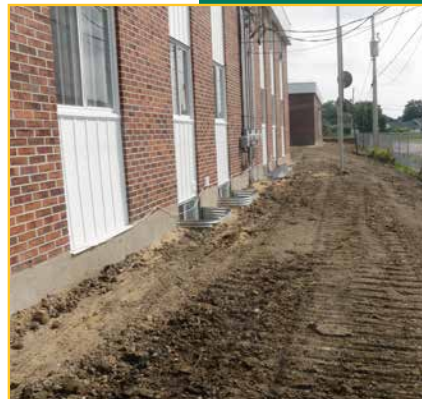
OMH de Thurso : réparation de la fondation et nivellement de terrain
